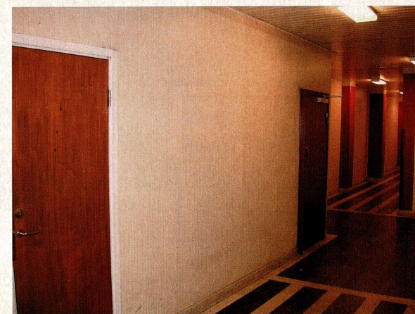
FÖRE Känslan av sjukhuskorridor var påtaglig innan renoveringen.
